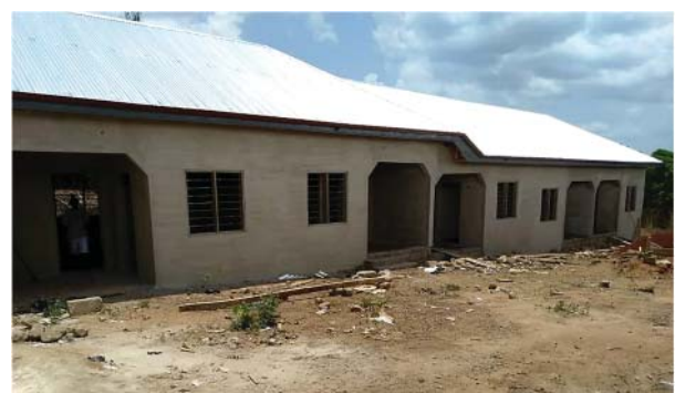
Die Bauarbeiten zum Lehrgästehaus sind im Frühjahr 2020 schon gut vorangeschritten.
